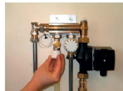
Poista termostaattiventtiin suoja.
