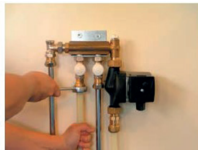
Sovita lattialämmityspiirin paluupuolen putki. Kiristä putki vasta, kun piiri on täyttynyt vedellä.
